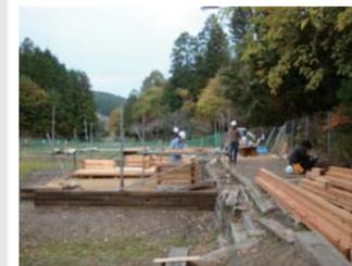
農小屋は、延床面積が約10㎡の平屋で、工法は一辺100mmの角材（一般には柱として使用）を寝かせ、縦横に積み重ねる校倉づくりで、災害時に誰もが施工に関われるよう配慮されています。建設作業は平成23年11月中旬から12月中旬の6日間に行われ、建築デザインコースの
